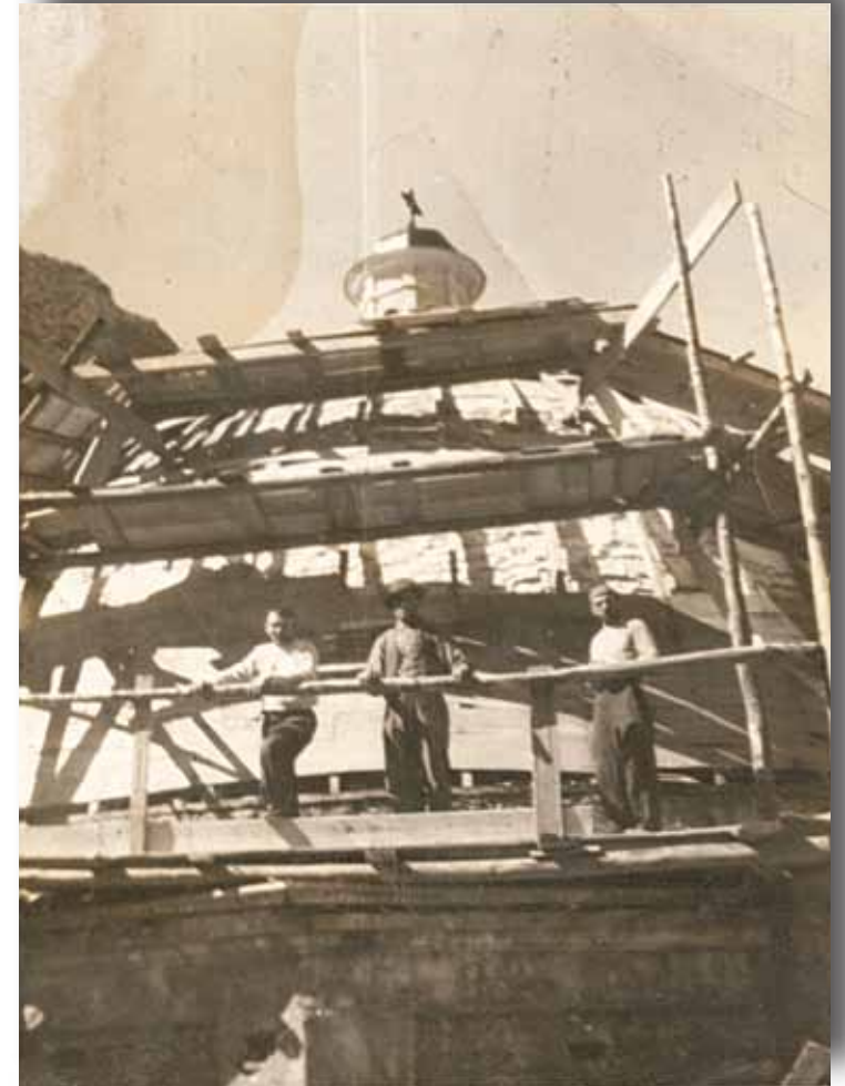
Sostituzione copertura della cupola - Anni 60°
