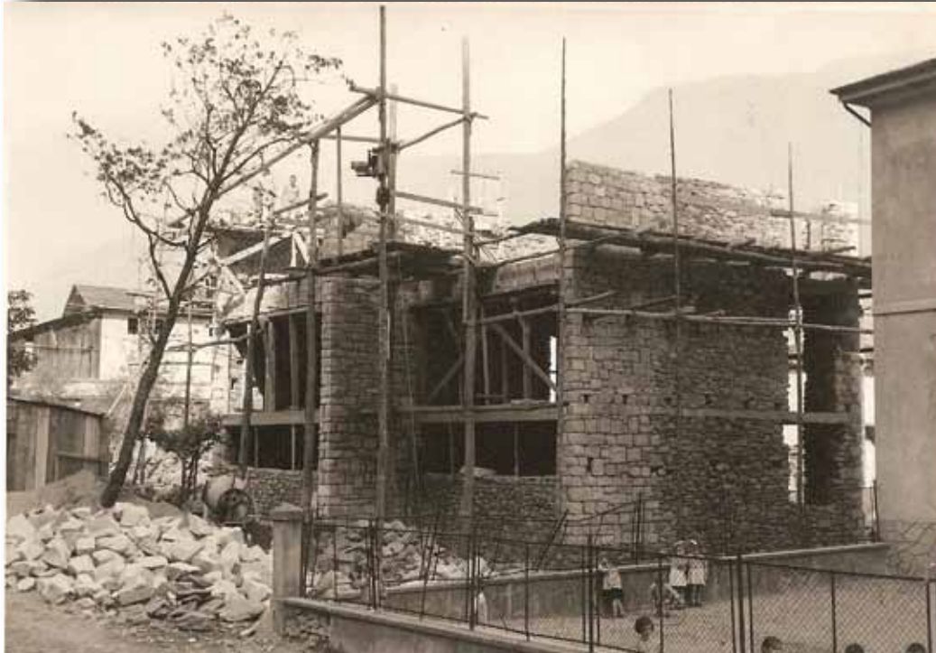
Le scuole elementari in costruzione - Sirta 1960
