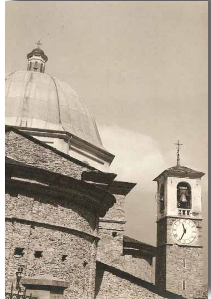
La copertura della cupola in lamiera - Sirta 1960
